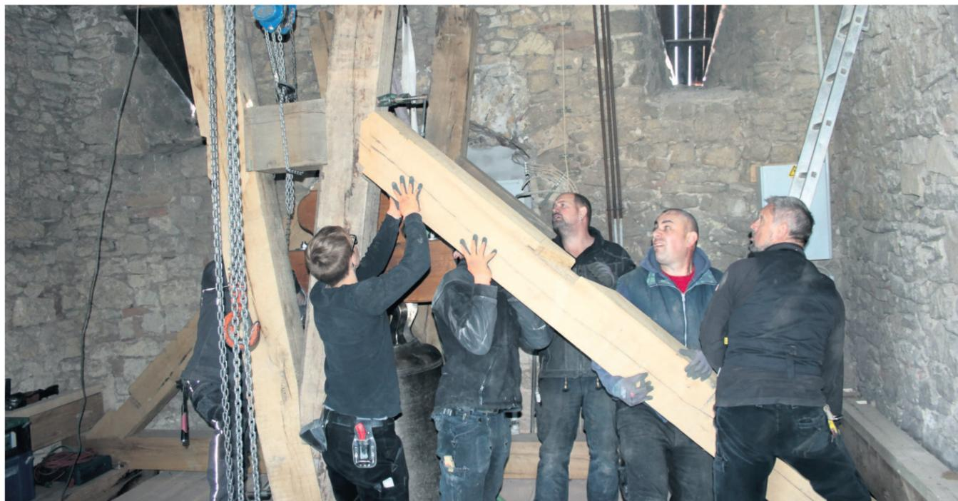
**Zimmerleute und Glockenbauer arbeiten Hand in Hand,** um nicht nur die Glocken zu platzieren, sondern auch um die schweren Eichenhölzer für den Glockenstuhl aufzurichten.
